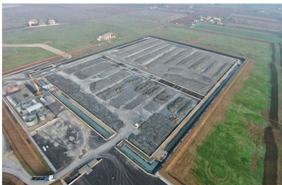
Figura 3 – Deposito intermedio C.na Romanellotta: predisposizione cumuli
