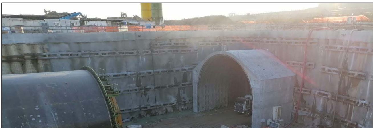
Avvio scavo – Galleria naturale di S.Giorgio in Salici – GN04
