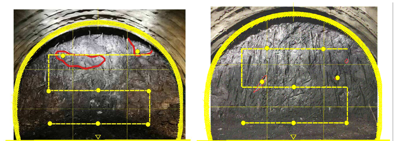
Figura 4 – Esempi di applicazione griglia Clerici per fronti di scavo non omogenei
