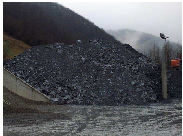
Figura 6 – Cumulo di smarino nella ribaltina di cantiere
