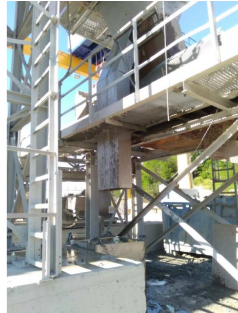
Figura 10 - Condotta di recapito degli incrementi di smarino in vasca di campionamento
