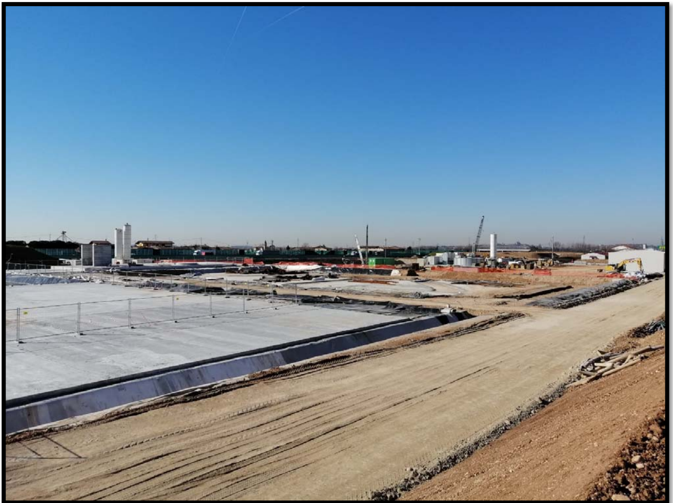
Cantiere di Lonato ovest – Comune di Lonato del Garda (BS)
